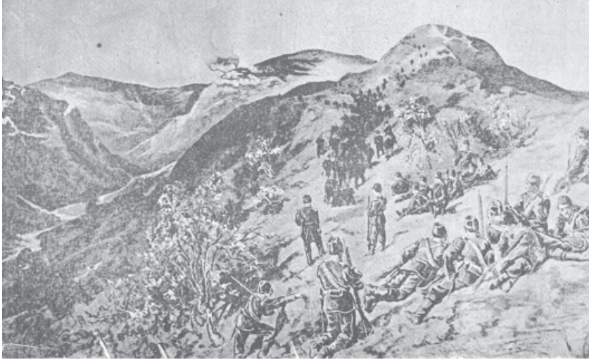
Kranya sınır çarpışmaları
