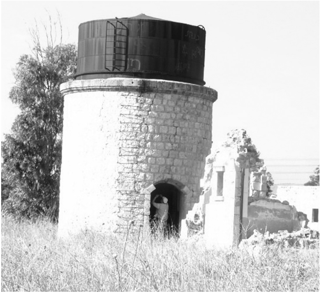
Şemamiye İstasyonu'ndaki su sarnıcının günümüzdeki hâli. Fotoğraf: M. Hülagü
