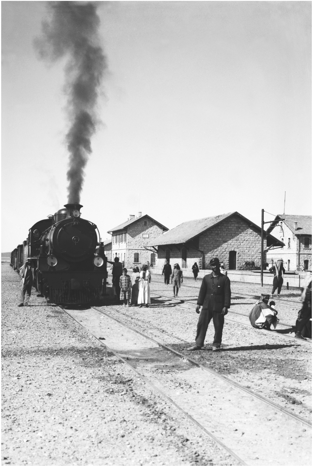
Hicaz Demiryolu'nun mühim duraklarından Maan İstasyonu. Kong. Ktp. Arşivi
