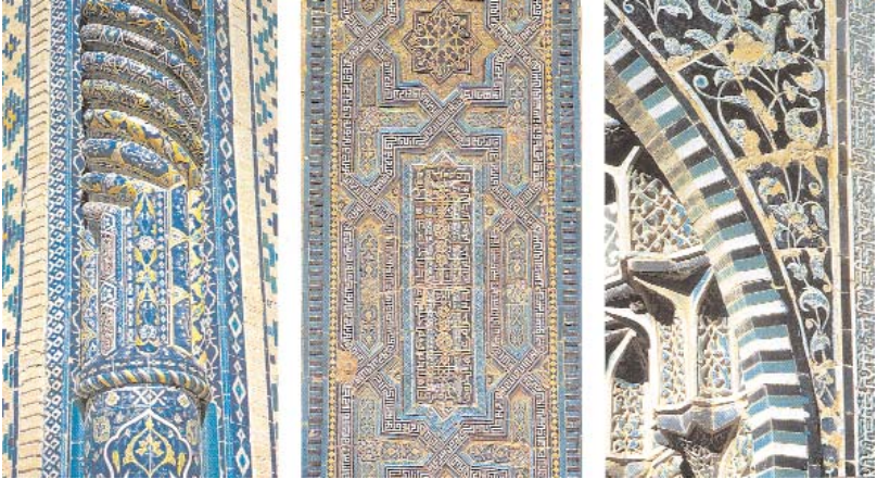
Semerkant'taki bazı medrese ve türbelerin cephesinden detaylar.
