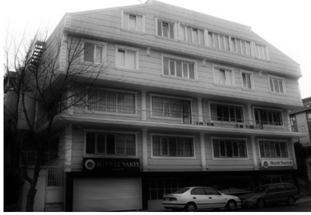
İstanbul Küçükçekmece'deki Hayrat Vakfi'nin binası.
